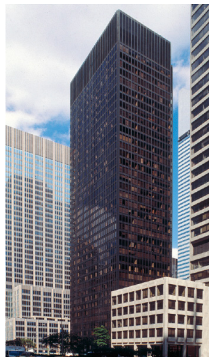
[ ] Mies van der Rohe y Philip Johnson. Seagram Building (1958). Esqueleto de acero y hormigón armado con revestimiento de vidrio. 157 metros de altura y 38 plantas. Nueva York.
