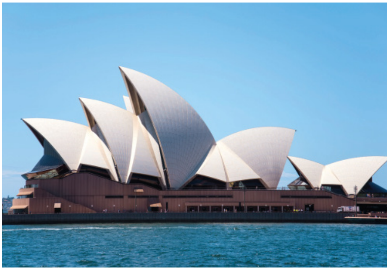
Jørn Utzon. Sydney Opera House (1957-1973). Hormigón, granito y revestimiento de azulejos. 67 metros de altura máxima y 183 x 120 metros en planta. Sydney (Australia).
