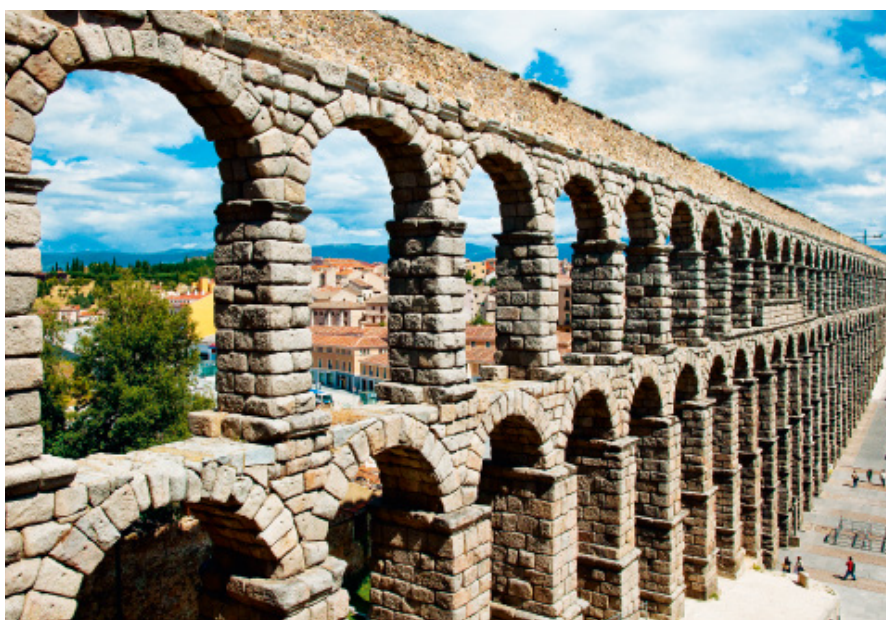
Acueducto de Segovia. Construido en tiempos de Domiciano y finalizado o reconstruido por Trajano. Finales del siglo I d.C. Granito. 800 m de longitud x 30 m de altura máxima.
